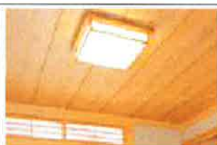
天井内装工事
