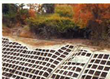
「斜面安定工事」
